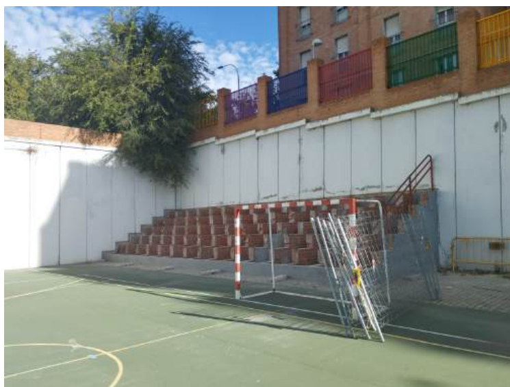
Gradas de la pista trasera. Se colocarán las vallas apoyadas en la portería.
