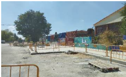
4: Acceso exterior al centro CPEE Vallecas
