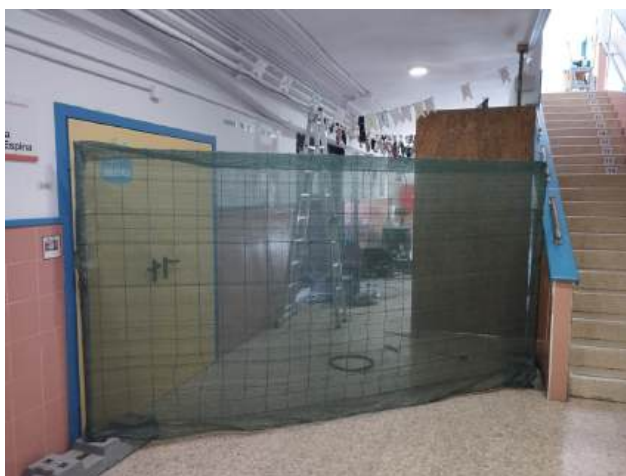
Pasillo planta baja y donde se está construyendo el ascensor. Se cubrirá con paneras de contrachapado por delante de la puerta amarilla a continuación del que está ya colocado.
