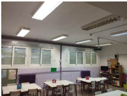
Ventanas nuevas en las aulas
