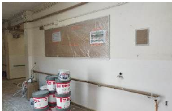
6: Pasillo de acceso a las aulas
